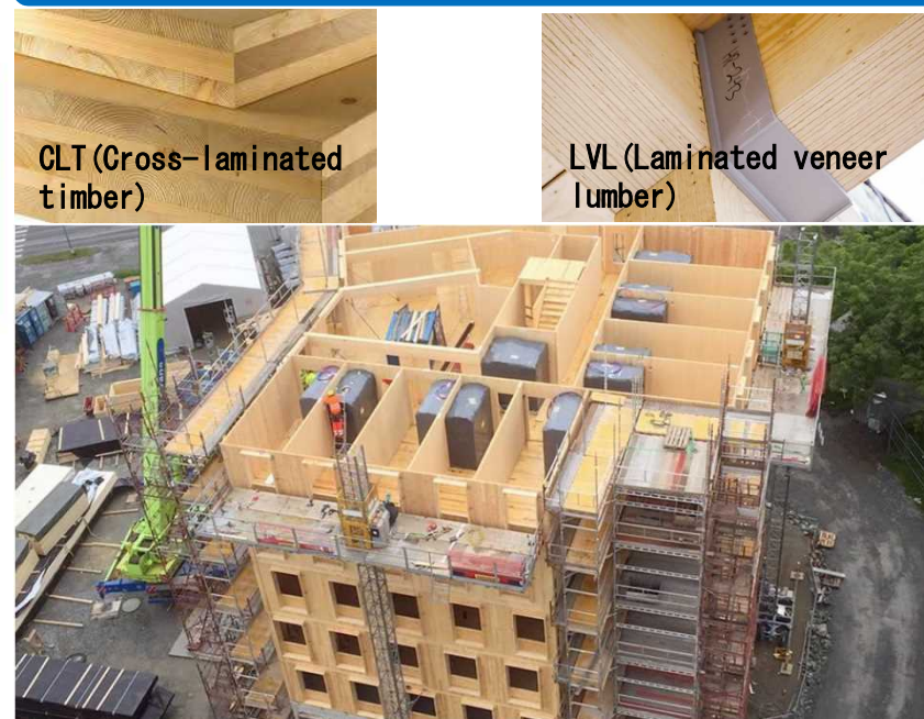
建設中の木造高層住宅 (Stora Enso)
